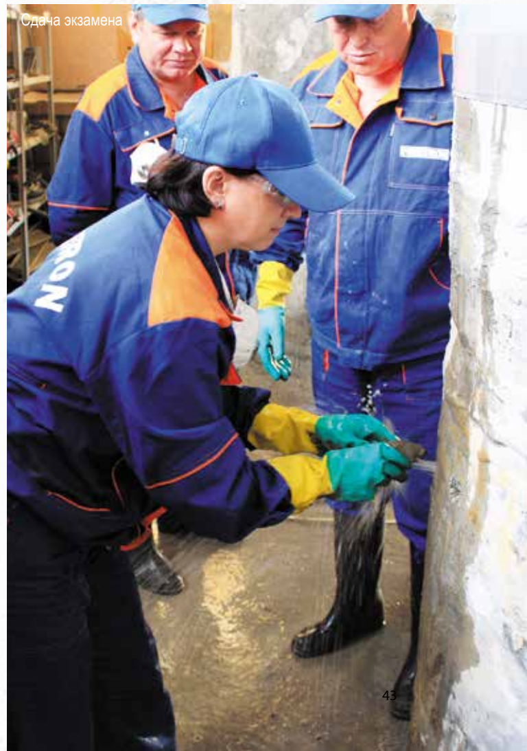
Гидроизоляция шва бетонирования
