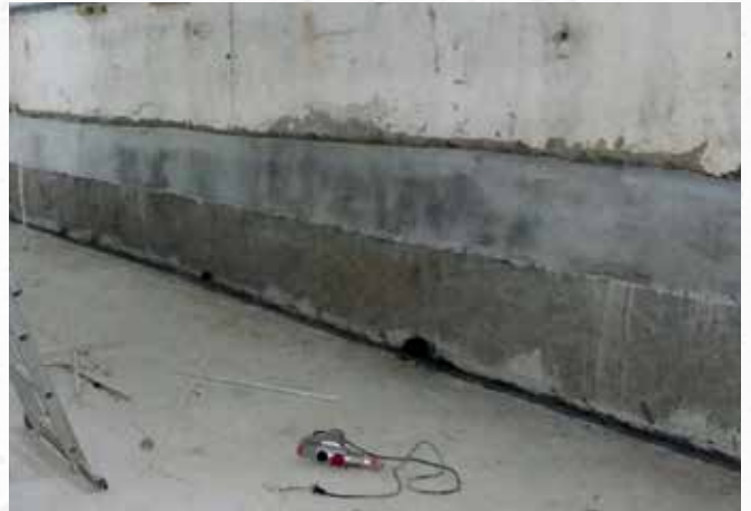
По окончании работ
