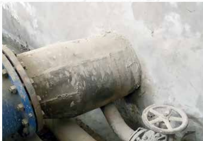
По окончании работ
