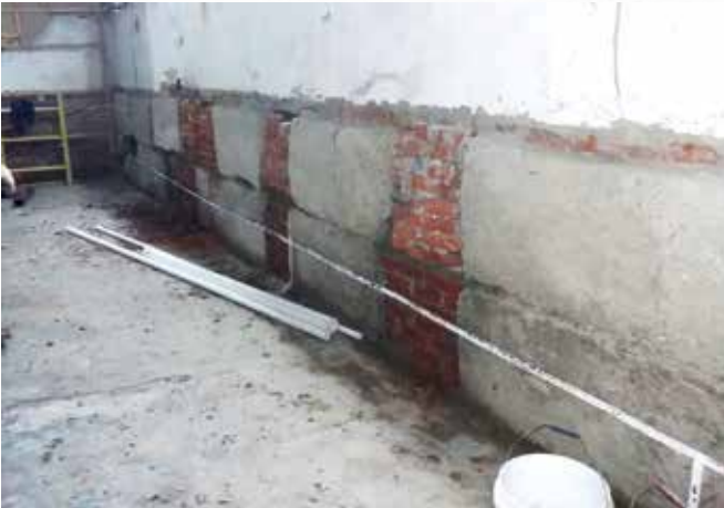
До начала работ
