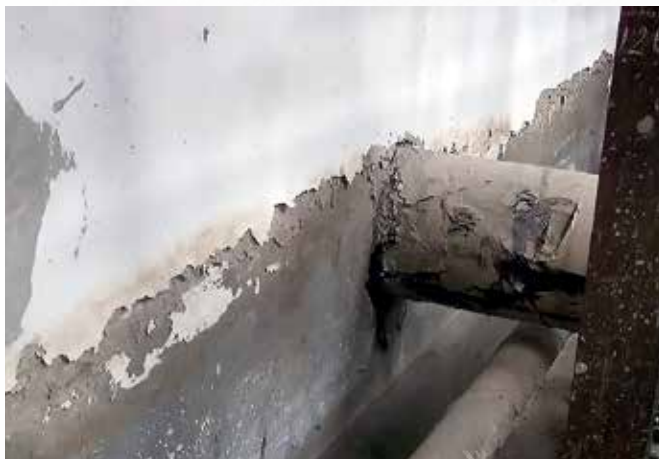
До начала работ
