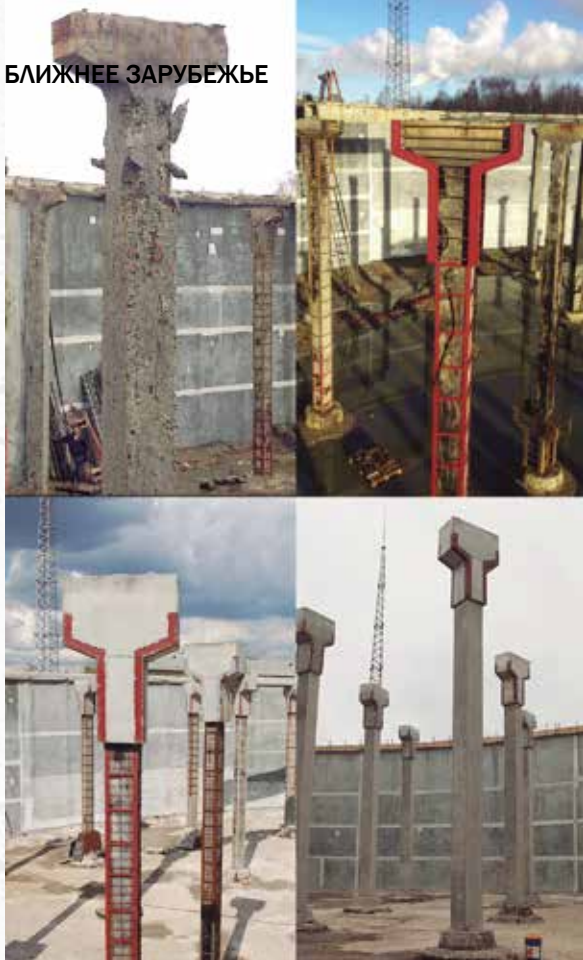
Колонны, на которые будет опираться кровля, для начала усилены металлокаркасом
