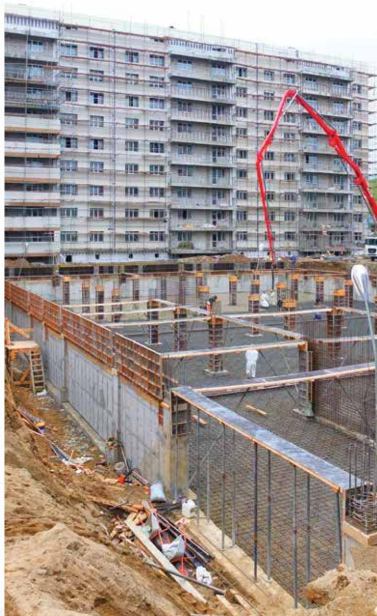
ству гидроизоляции паркинга. Мы обеспечили заказчика консультациями и техническим надзором на всех этапах проведения работ. Не оставили без внимания и лаборатории на бетонно-растворном узле. На втором паркинге плита основания заливалась целиком в течение суток.
