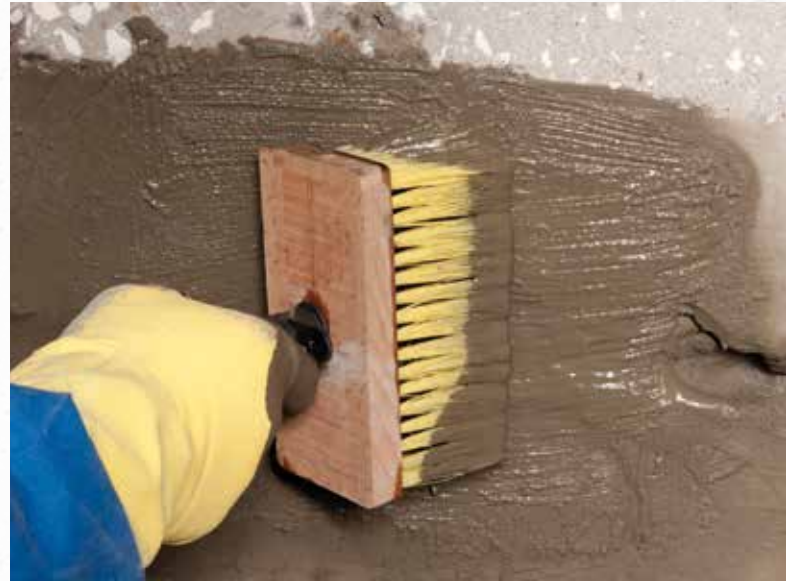
Рисунок 11 – Обработка штрабы растворной смесью «Пенетрон»
