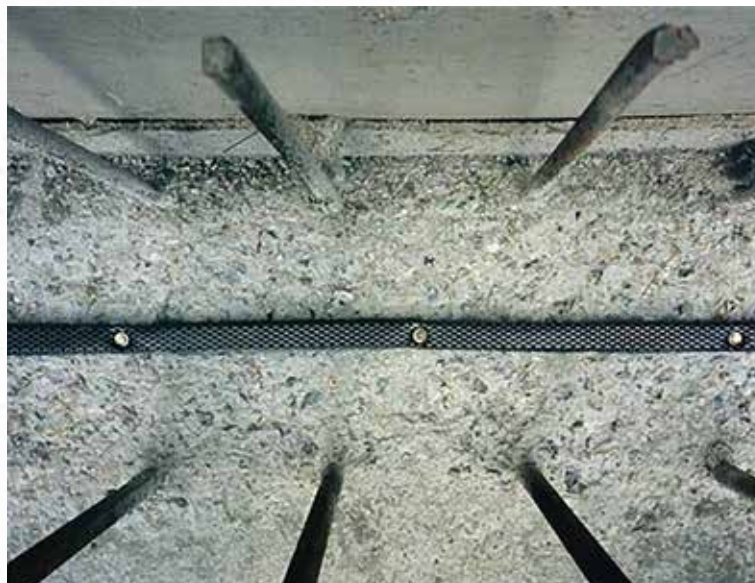
Рисунок 7 – Монтаж гидроизоляционного жгута «Пенебар» (вид сверху)
