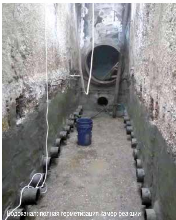
Восстановление бетонных конструкций с помощью «Скрепы М700»
