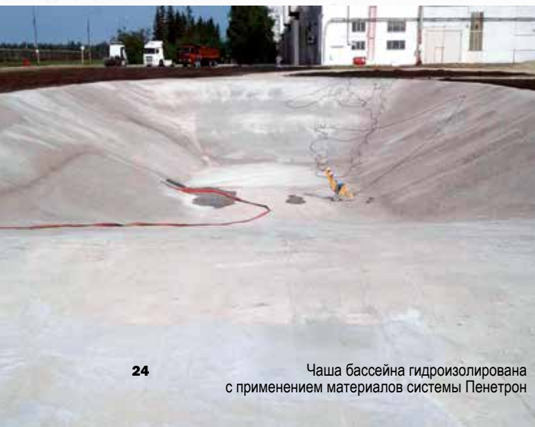
Чаша бассейна состоит из двух частей: необходимо гидроизолировать стык
