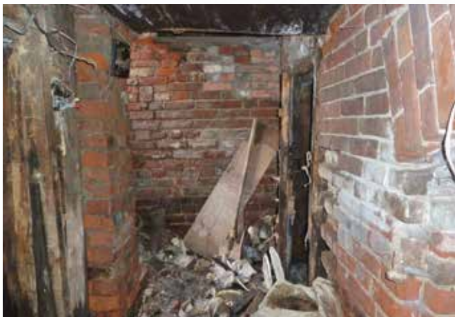
До начала работ
