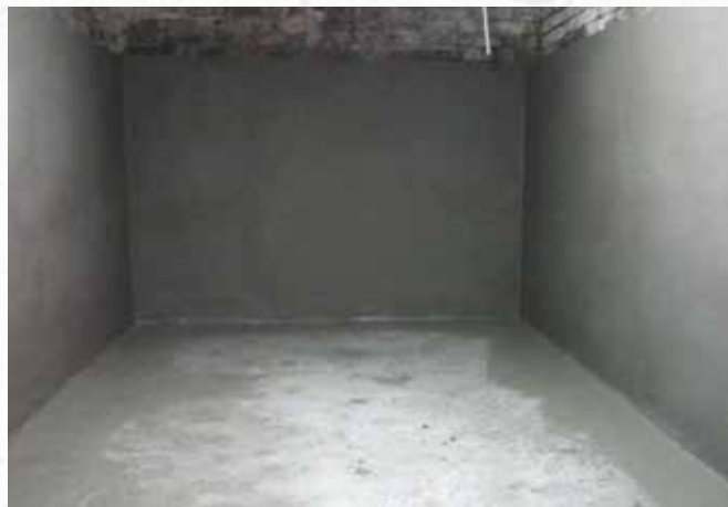
По окончании работ
