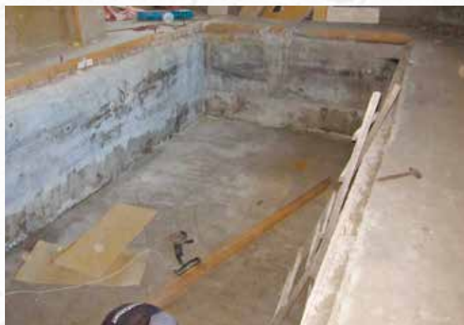
По окончании работ
