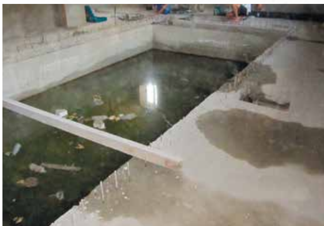
До начала работ
