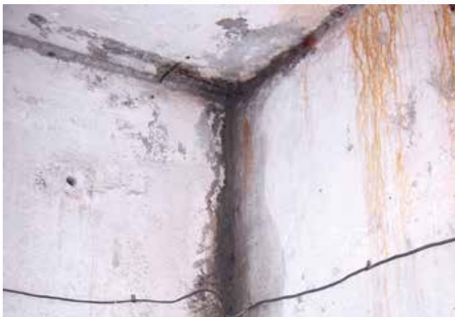
До начала работ
