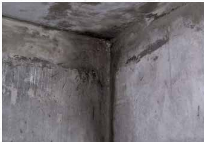
По окончании работ
