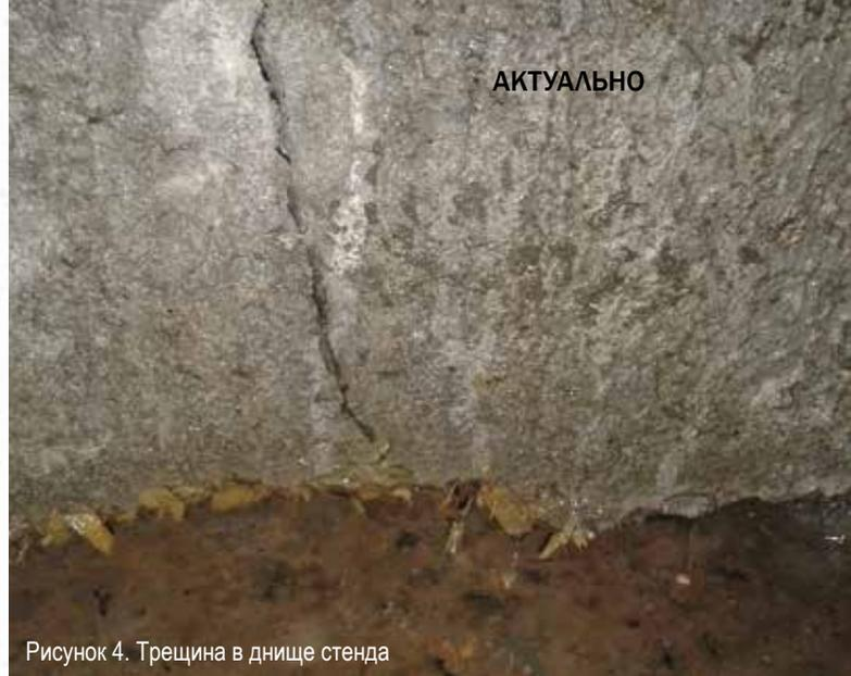
Рисунок 4. Трещина в днище стенда
