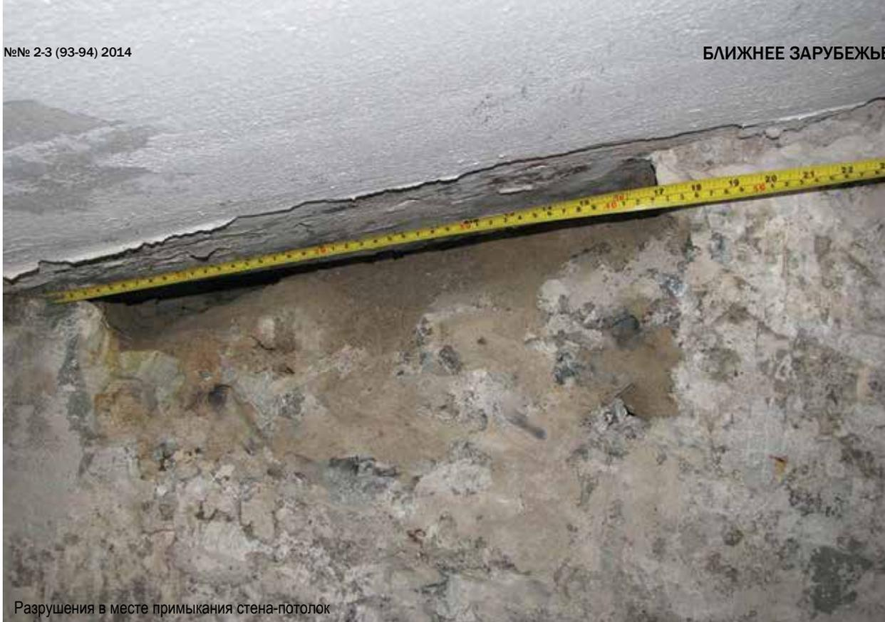
Разрушения в месте примыкания стена-потолок
