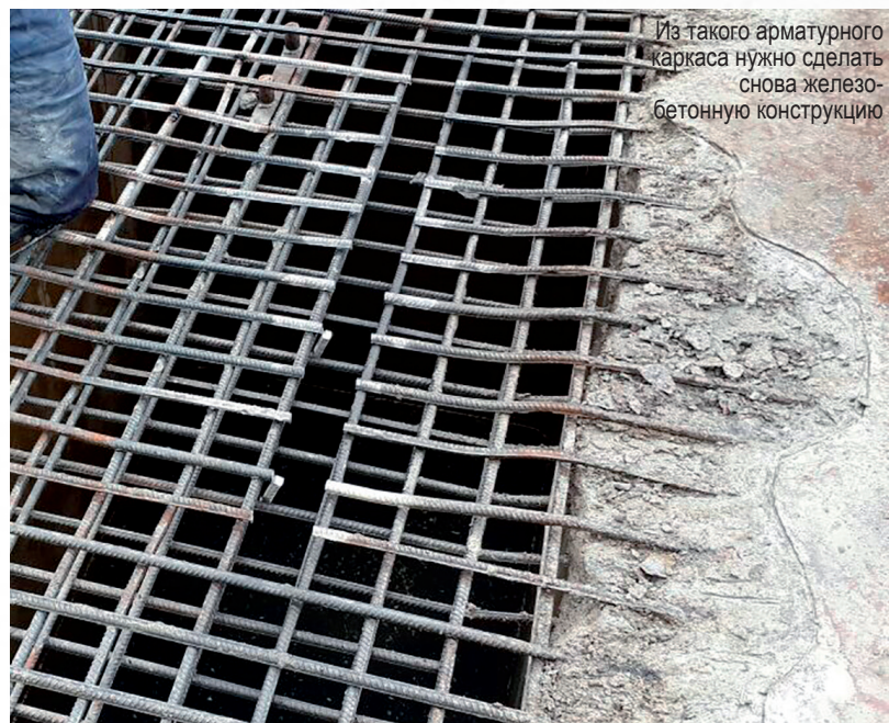
Подготовка к восстановлению поврежденной поверхности
