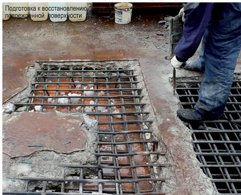
Из такого арматурного каркаса нужно сделать снова железобетонную конструкцию
