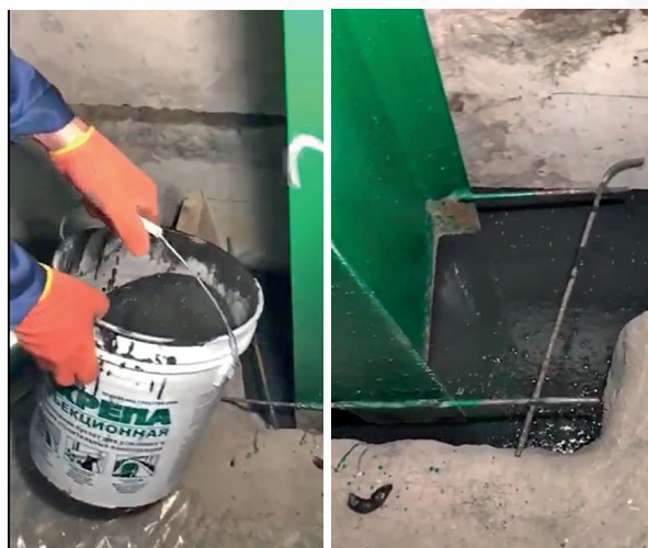
Рис. 6. Заливка растворной смеси «Скрепа М600 Инъекционная»
