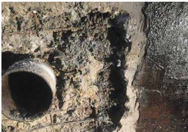
До начала работ
