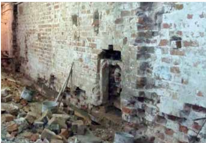
До начала работ
