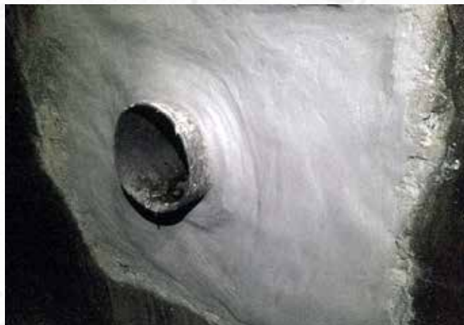
По окончании работ
