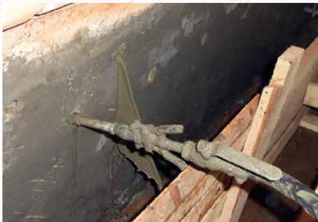
По окончании работ
