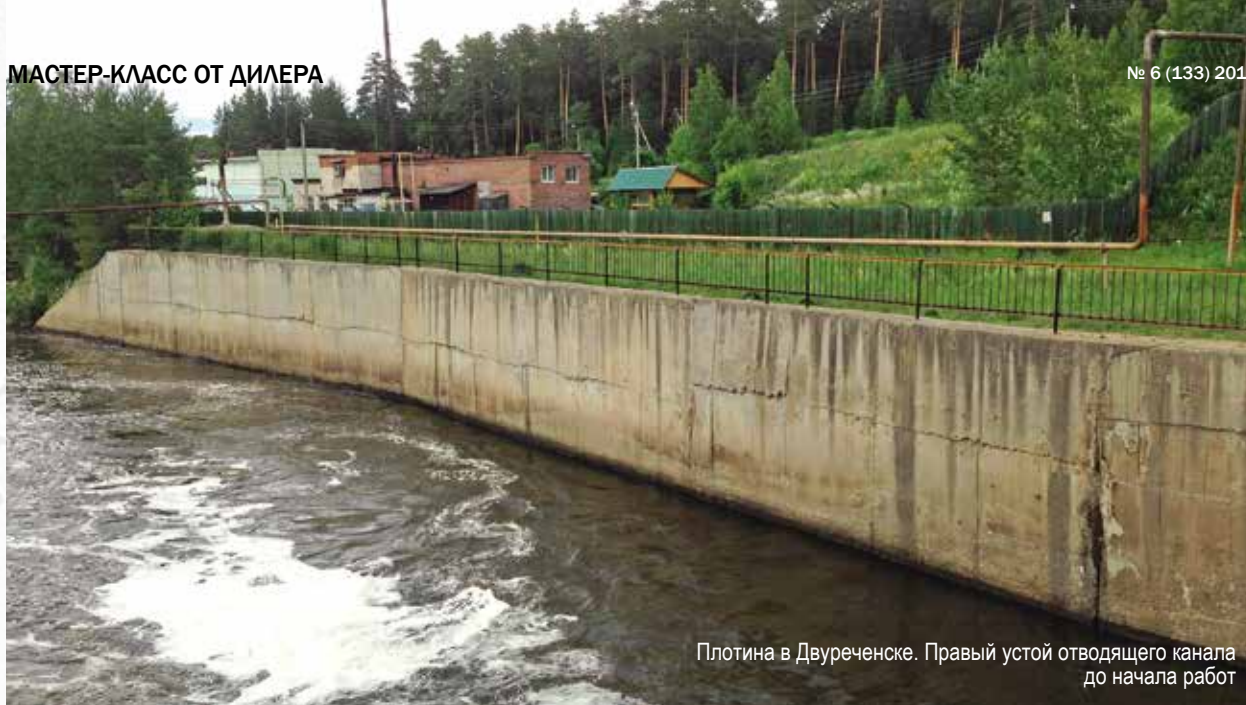
Подготовительный этап гидроизоляционных работ
