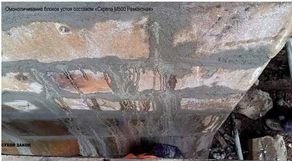
Омоноличивание блоков устоя составом «Скрепа М500 Ремонтная»
