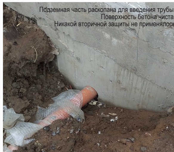
Смонтирован гидроизоляционный жгут «Пенебар»
