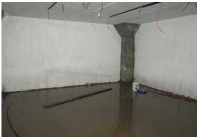
До начала работ
