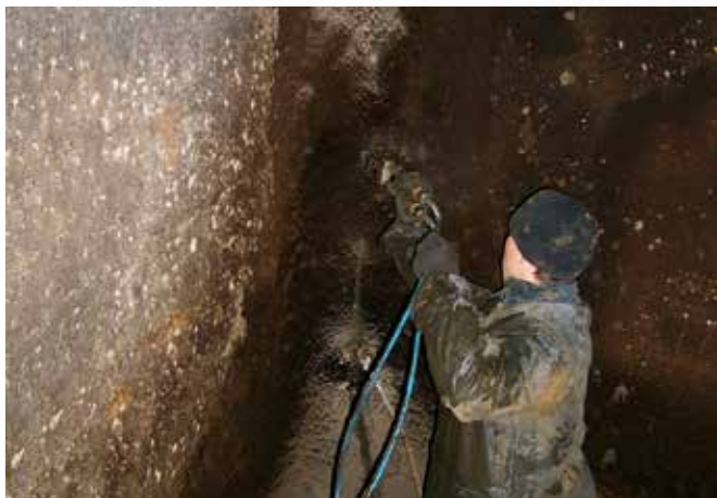
До начала работ
