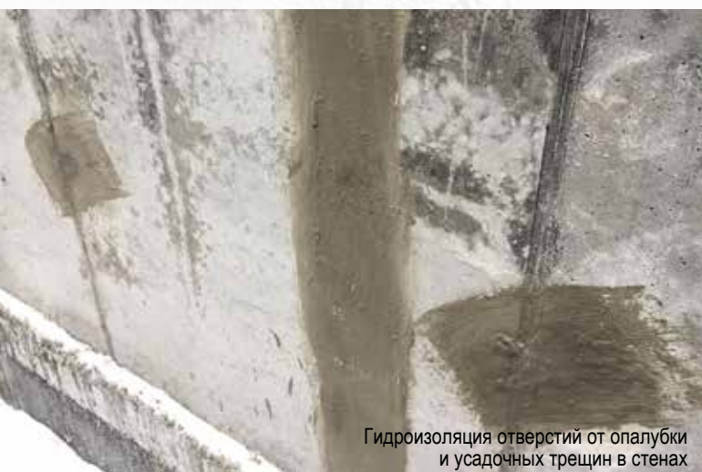
Подвал ЖК «Эверест»
