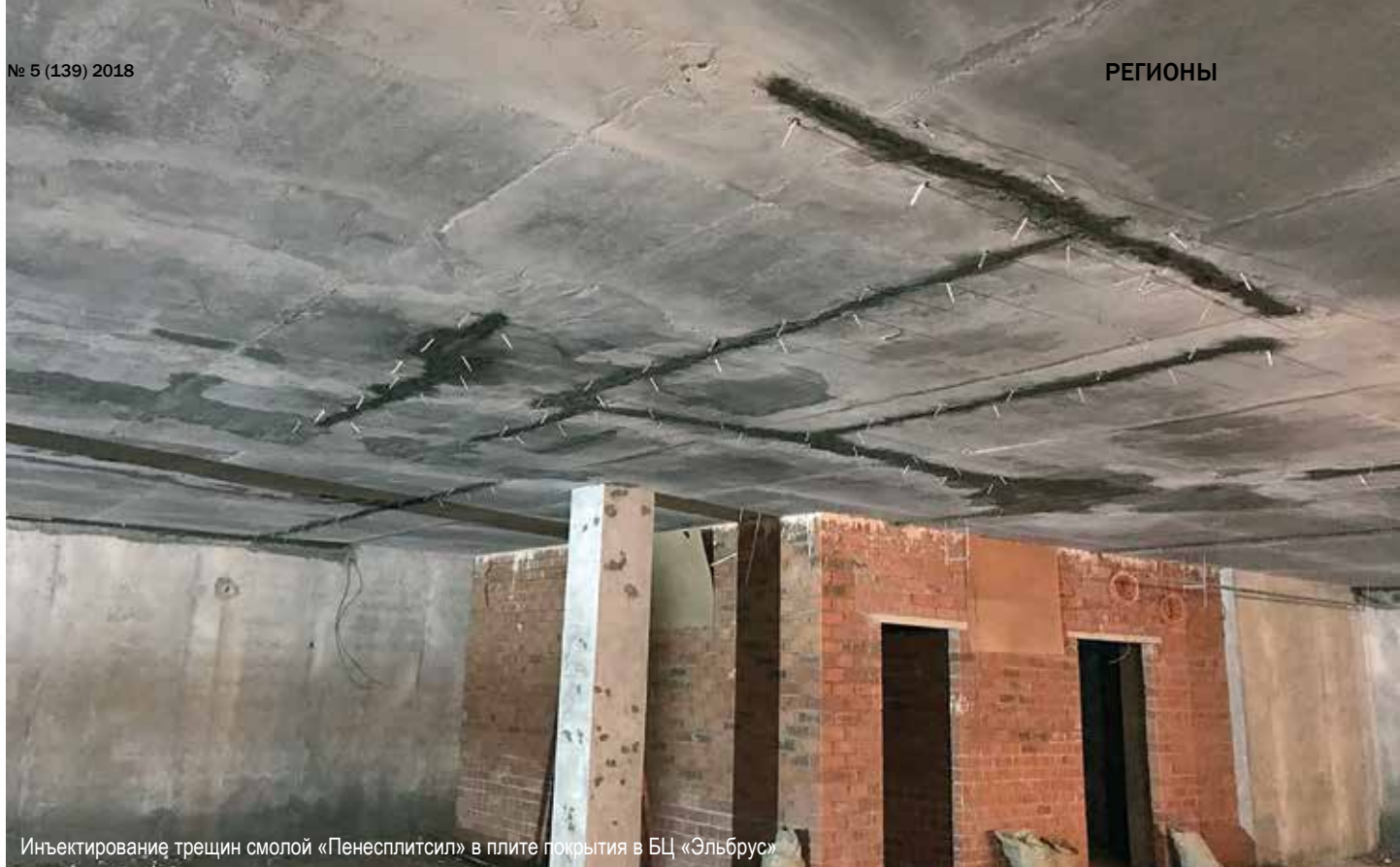
Гидроизоляция рабочих швов «Пенетроном» и «Пенекритом» в плите покрытия БЦ «Эльбрус»
