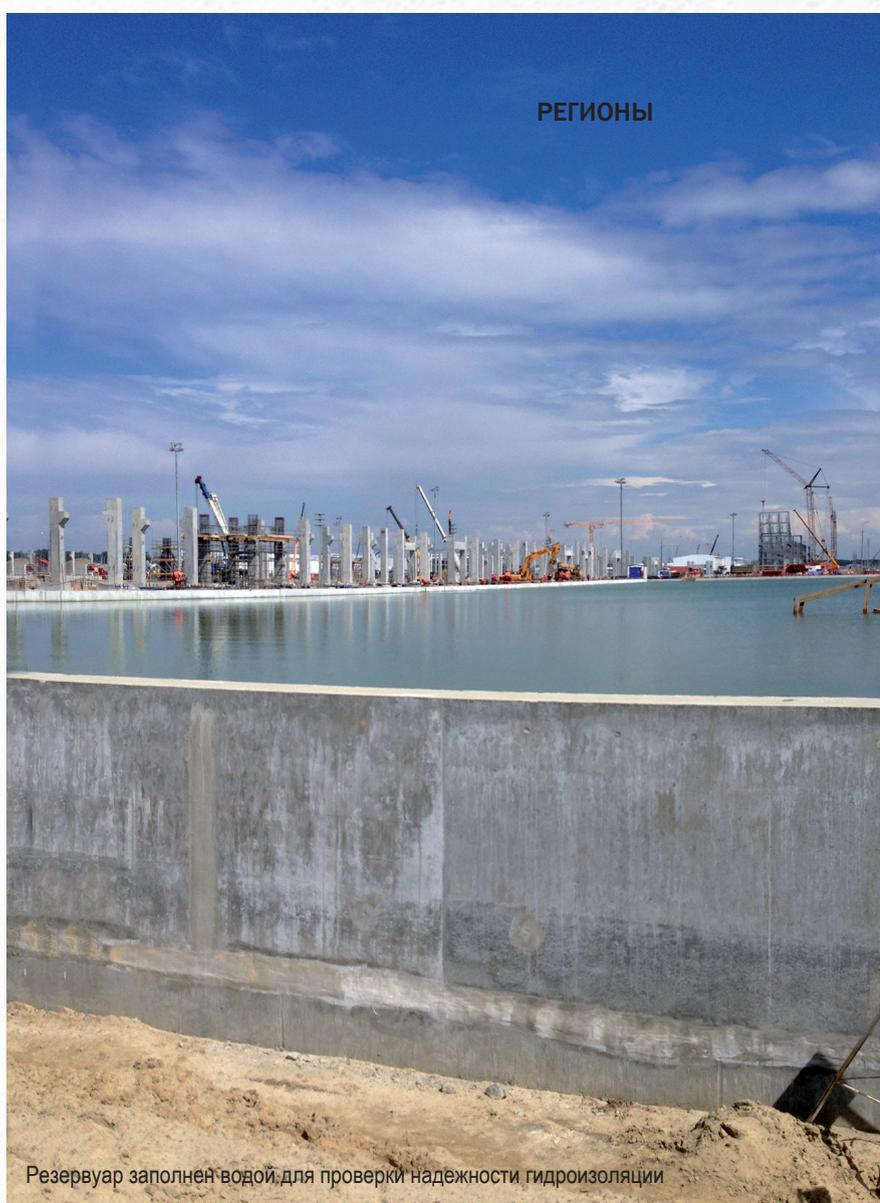
Резервуар заполнен водой для проверки надежности гидроизоляции
