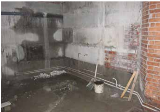
До начала работ
