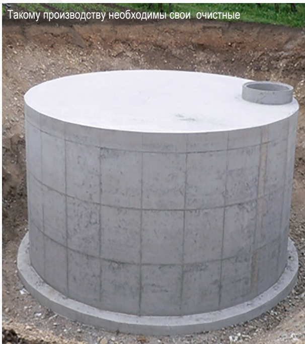
Сопряжения бетонных конструкций герметизирует «Пенекрит»
