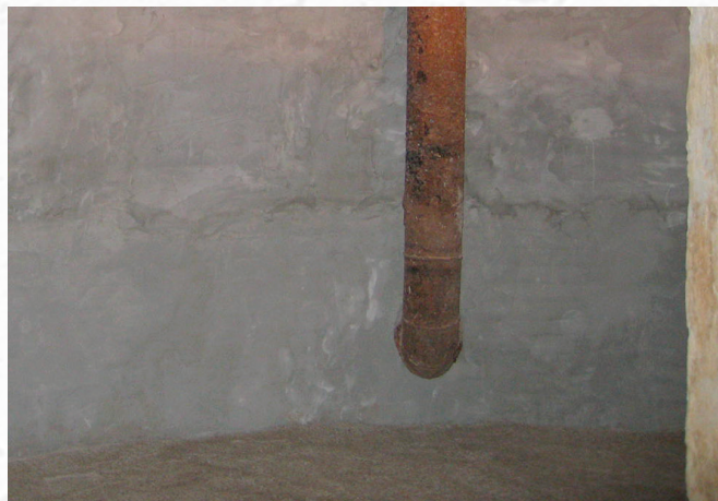
По окончании работ
