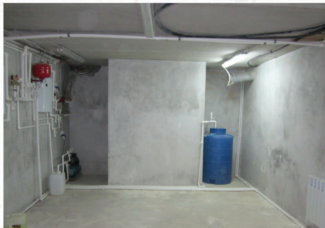
По окончании работ
