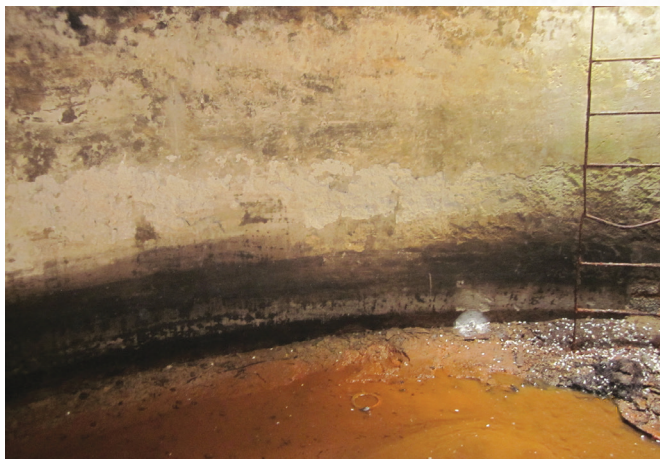
До начала работ
