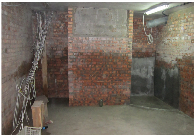
До начала работ
