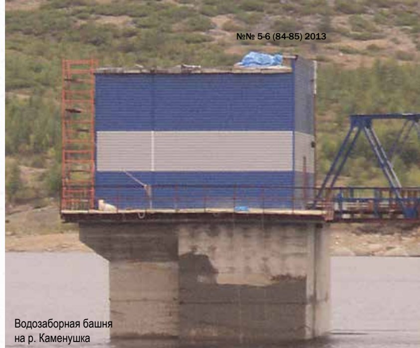
Выполнение гидроизоляционных работ промышленными альпинистами
