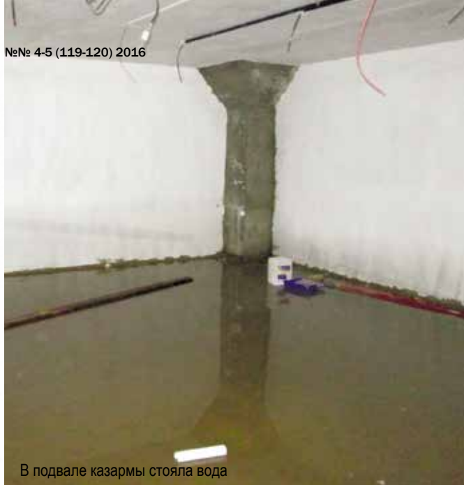
Качество гидроизоляции проверено талыми водами
