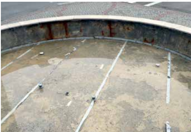
До начала работ
