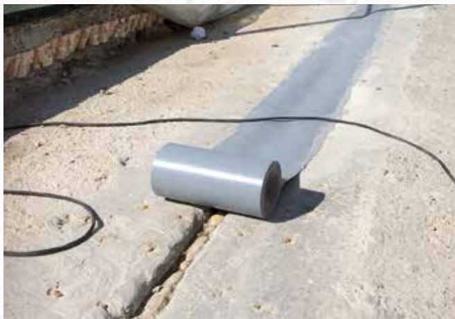
По окончании работ
