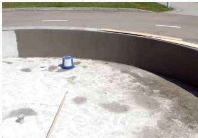
По окончании работ
