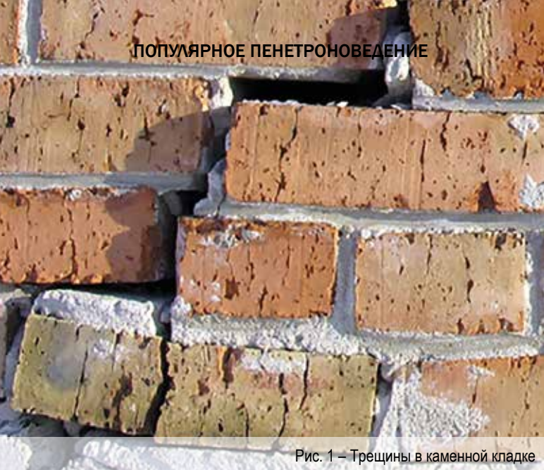
Рис. 2 - Разрушение отдельных кирпичей вследствие воздействия влаги и знакопеременных температур
