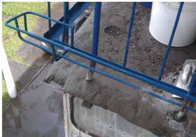
По окончании работ
