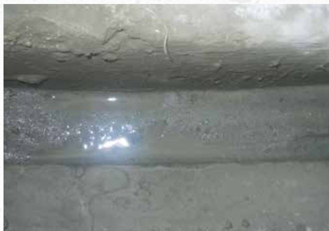
По окончании работ
