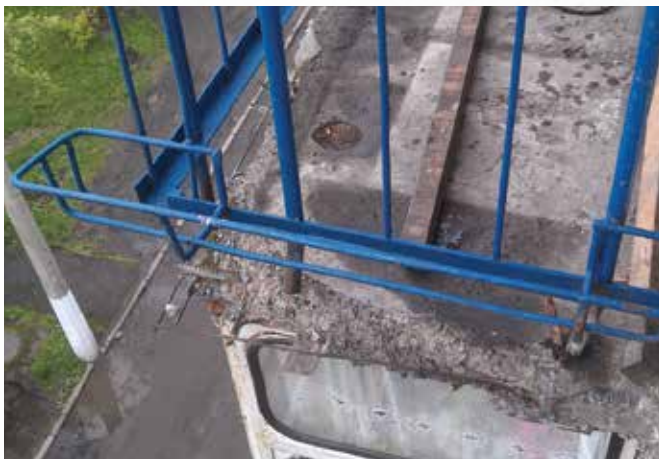
До начала работ
