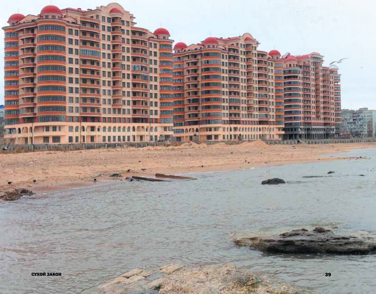
Общий вид жилого комплекса
