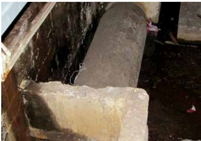
До начала работ
