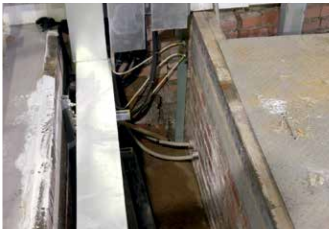
До начала работ
