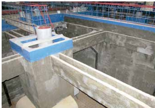
По окончании работ
