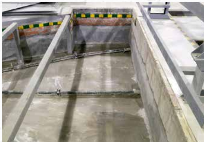
По окончании работ
