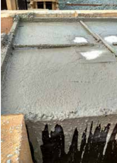
Бетонирование с добавкой «Пенетрон Адмикс»
