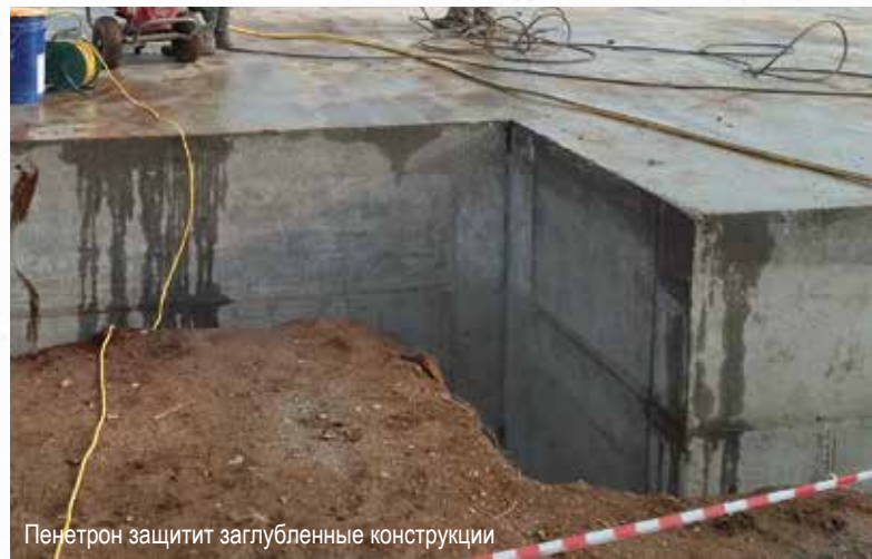
Бетонирование с добавкой «Пенетрон Адмикс»
