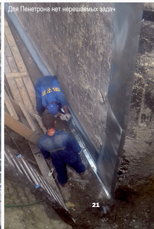
Сейсмокомпенсационный пояс на 4-метровой глубине
