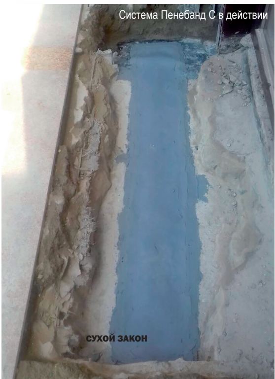
Сейсмокомпенсационный пояс на 4-метровой глубине
