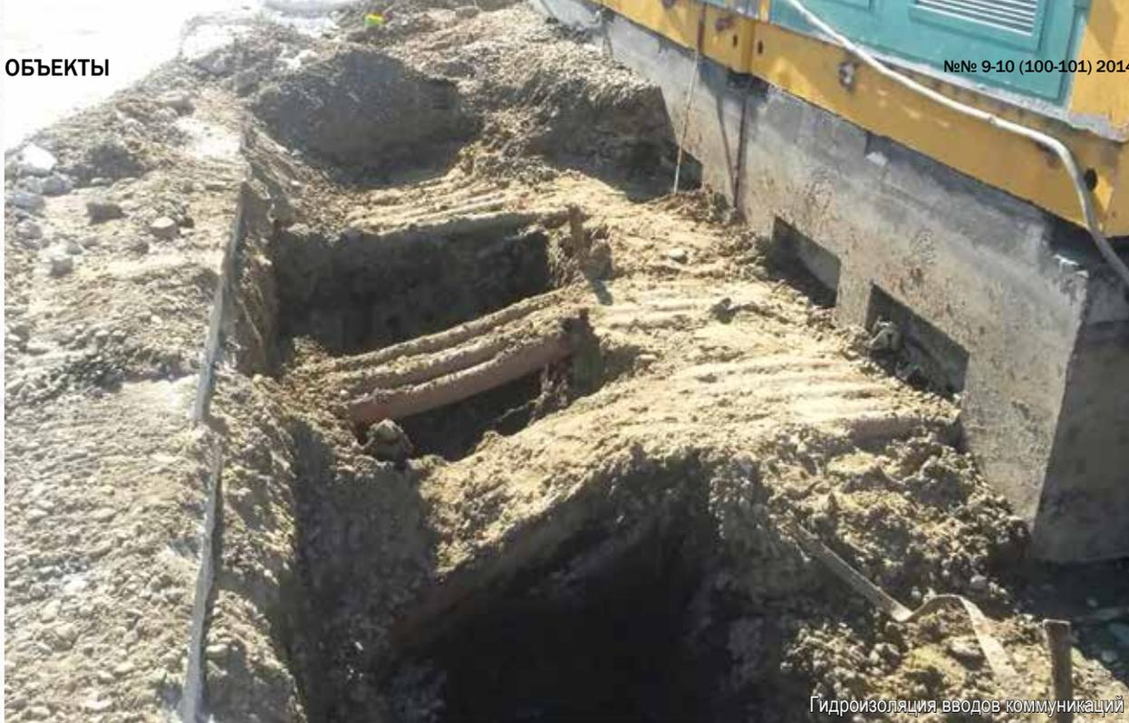
гидроизоляцию мест вводов кабелей с помощью гидроизоляционного жгута «Пенебар», состава «Пенекрит» и гидроизоляционной проникающей капиллярной смеси «Пенетрон». Гидроизолировали швы примыкания материалами «Пенекрит» и «Пенетрон», эти же смеси были использованы для обеспечения водонепроницаемости швов в колодце. Вся бетонная поверхность также была обработана гидроизоляционным материалом «Пене-
