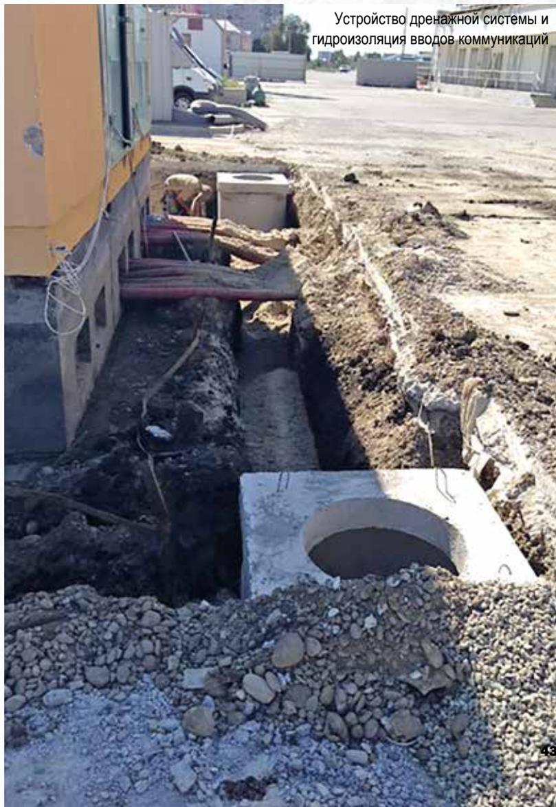
Устройство дренажной системы и гидроизоляция вводов коммуникаций
