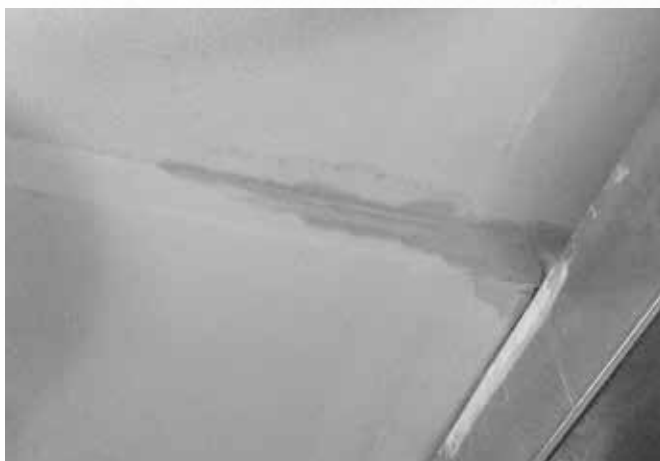
До начала работ
