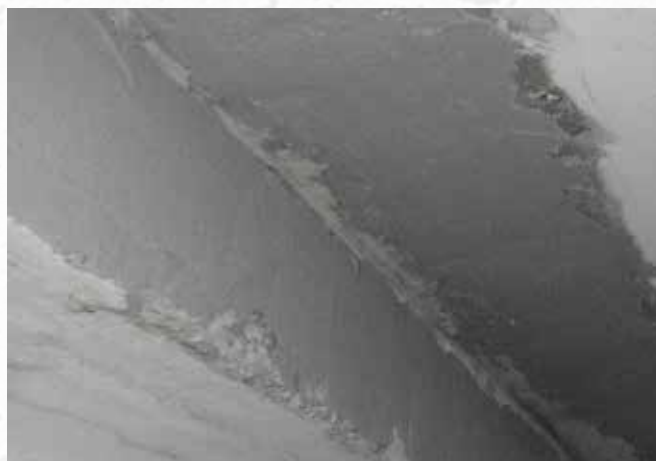
По окончании работ
