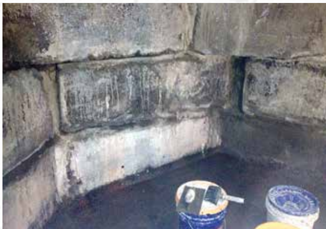
По окончании работ
