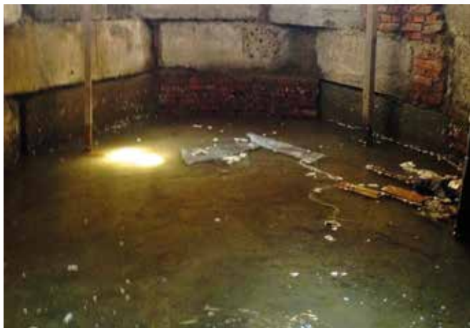
До начала работ
