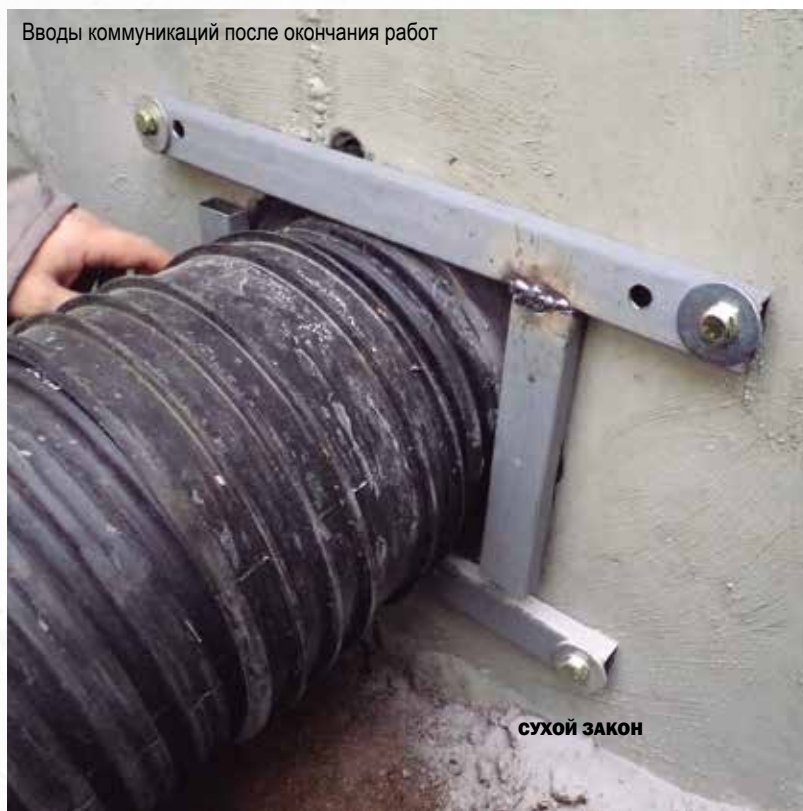
Герметизация мест вводов коммуникаций клеем-герметиком «Пенепокси»
