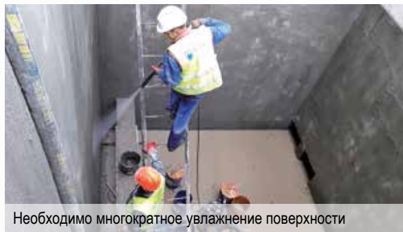
Увлажнение поверхности механизированным способом
