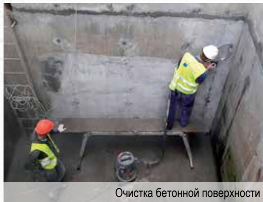
Первичный осмотр объекта
