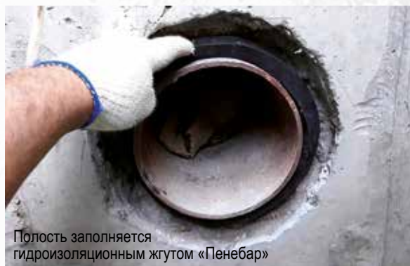
Уплотнение штрабы материалом «Пенекрит»
