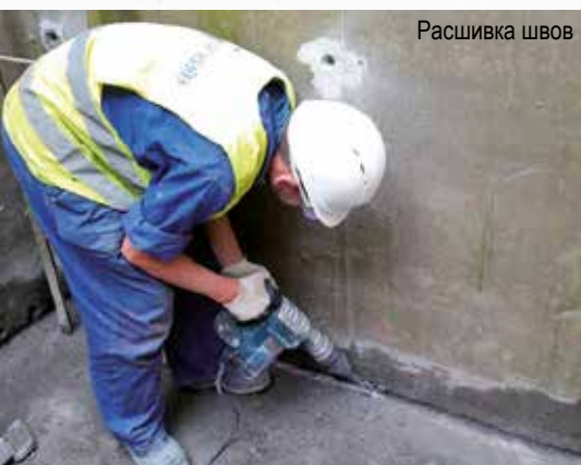
Гидроизоляция шва по технологии «Пенетрон» + «Пенекрит»
