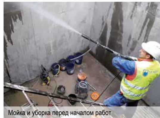
Очистка бетонной поверхности
