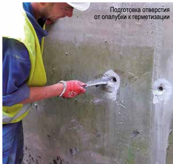
Гидроизоляция отверстий с применением материала «Пенекрит»
