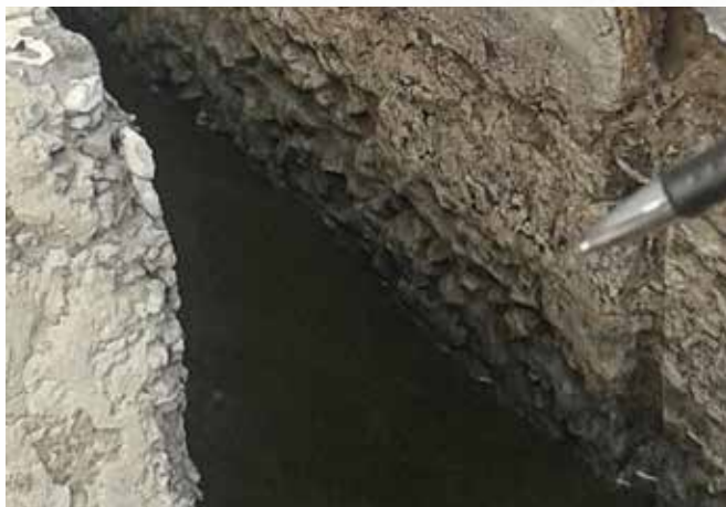
До начала работ
