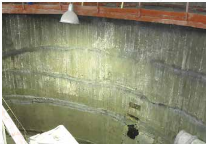
По окончании работ
