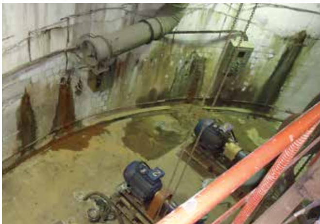
До начала работ
