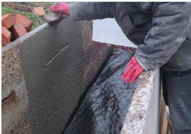
По окончании работ
