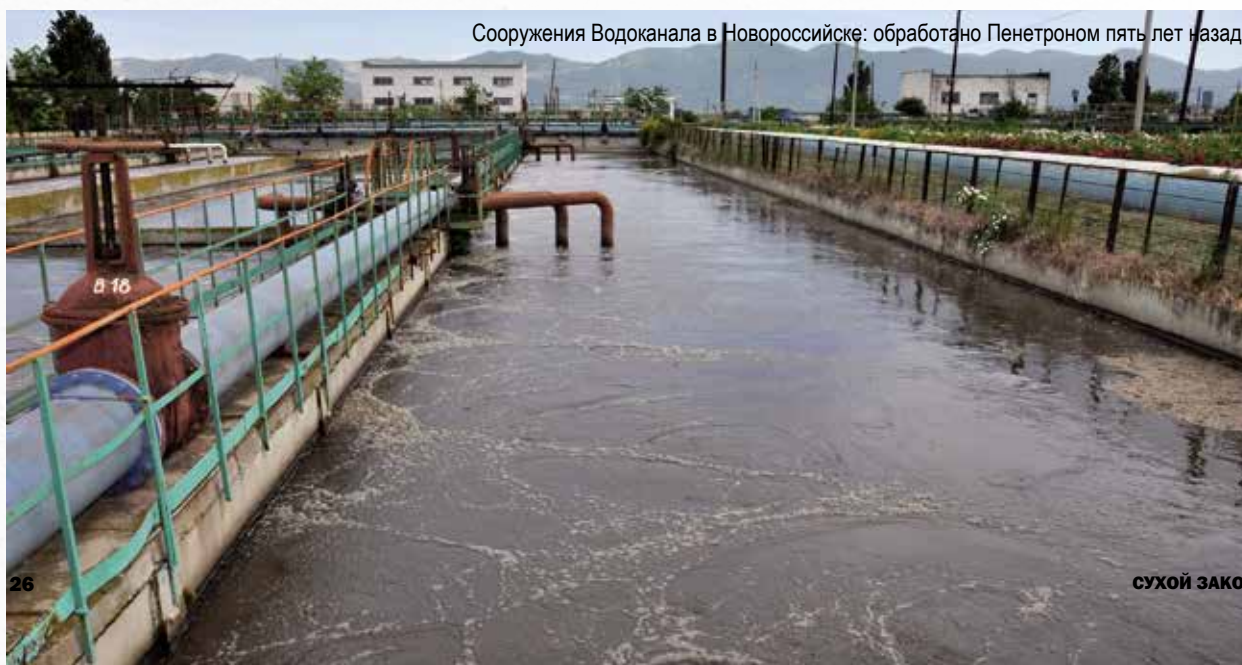
Ремонт резервуара на Водоканале города Сочи: для восстановления конструкций используется «Скрепа М500 Ремонтная»
