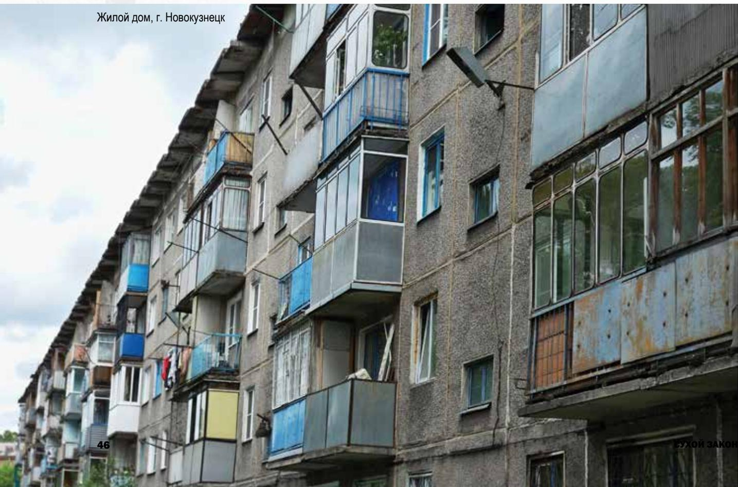
дилера ГК «Пенетрон-Россия» сначала привлекали на восстановление гидроизоляции кровли 10-подъездного жилого дома, а спустя некоторое время с его помощью новую жизнь обрели балконные плиты. Они начали разрушаться в ходе эксплуатации, теряя геометрические размеры и оголяя арматуру. С помощью материалов системы Пенетрон, а также «Скрепы М500 ремонтной» этот процесс удалось остановить.
