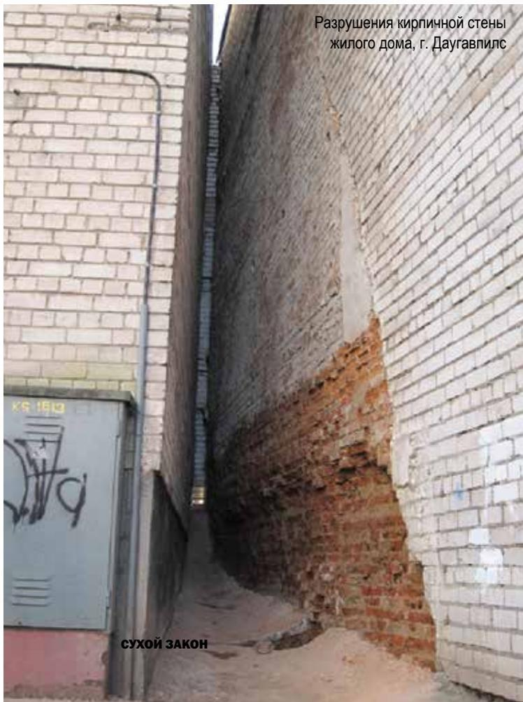
Разрушения кирпичной стены жилого дома, г. Даугавпилс
