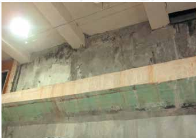
По окончании работ
