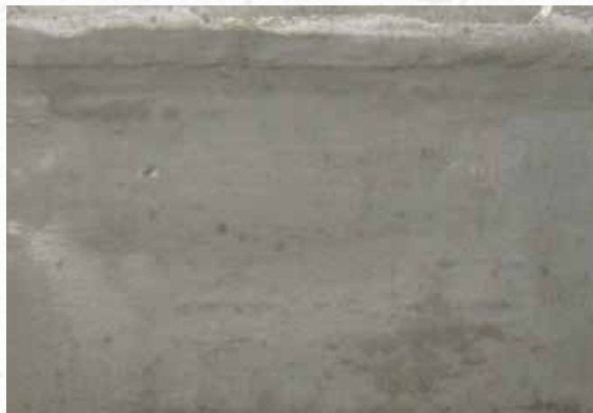
По окончании работ
