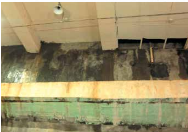
До начала работ
