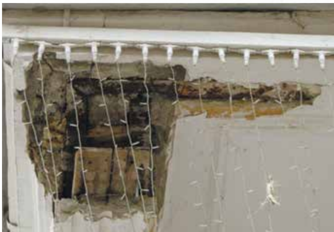
До начала работ
