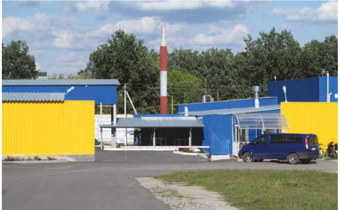
До начала работ
