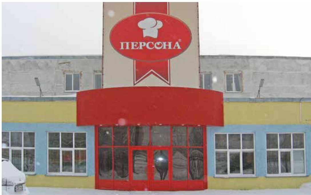
До начала работ
