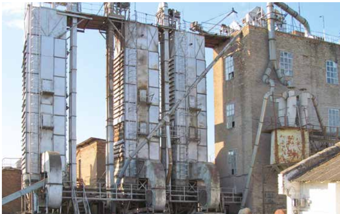
До начала работ
