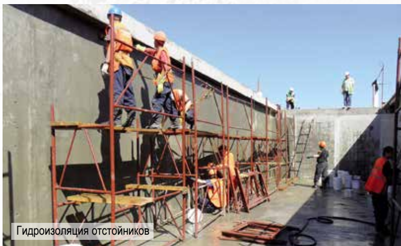
Восстановление защитного слоя «Скрепой М500» в крайне стесненных условиях
