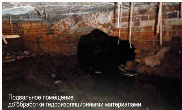
Подвальное помещение до обработки гидроизоляционными материалами
