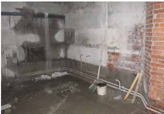
До начала работ
