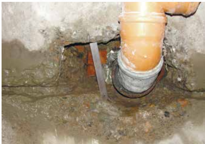
До начала работ
