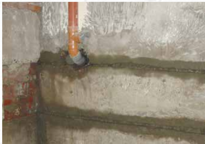
По окончании работ
