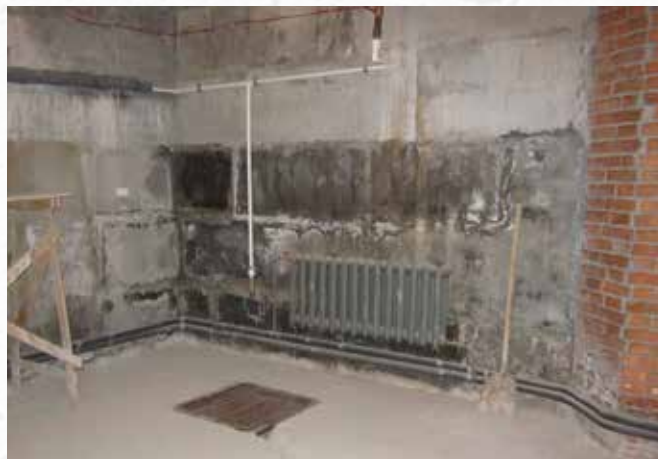
По окончании работ
