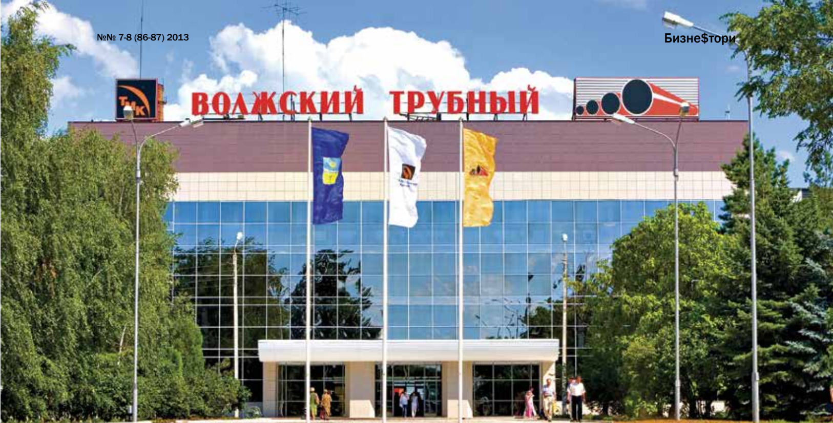
Волжский трубный завод
