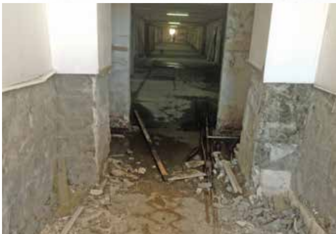
До начала работ
