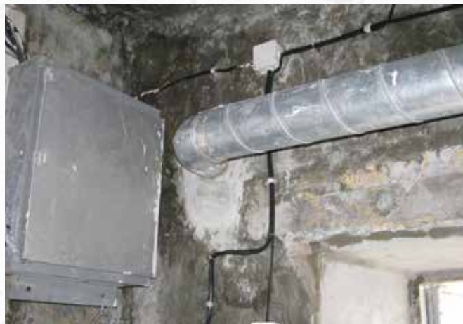
По окончании работ
