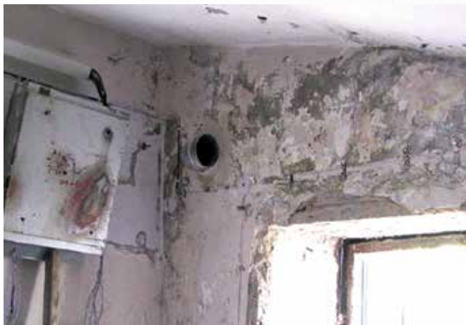
До начала работ
