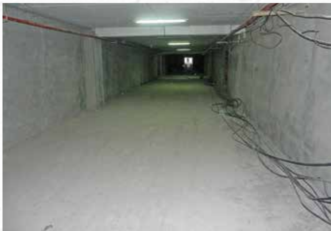
По окончании работ
