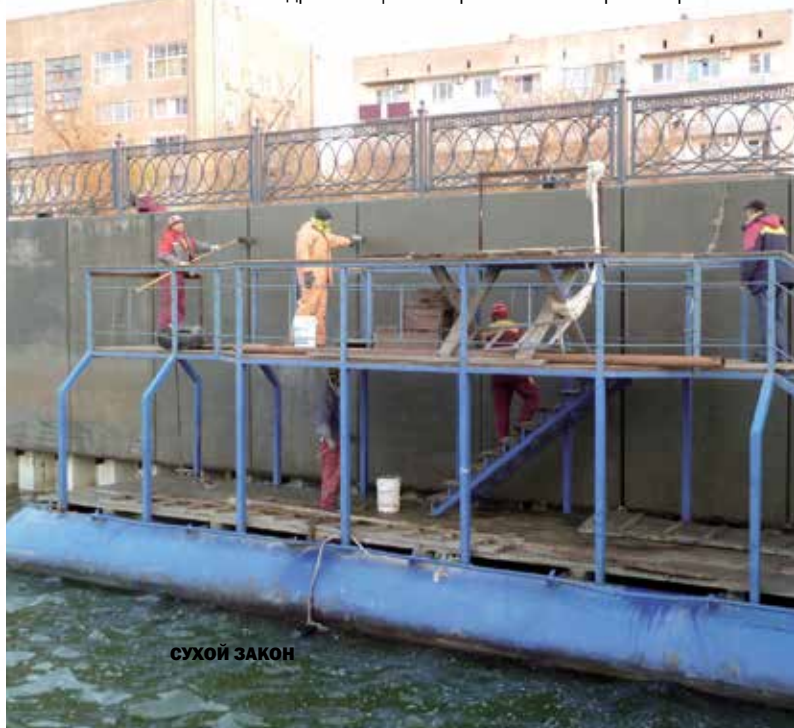
Гидроизоляционные работы на набережной реки Волга
