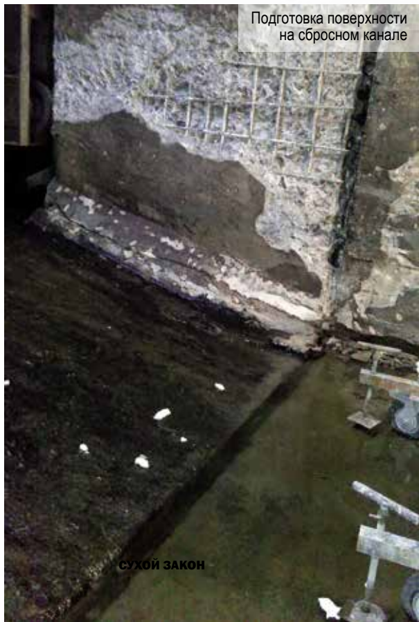
Заливка новой стяжки из «Скрепы М600»
