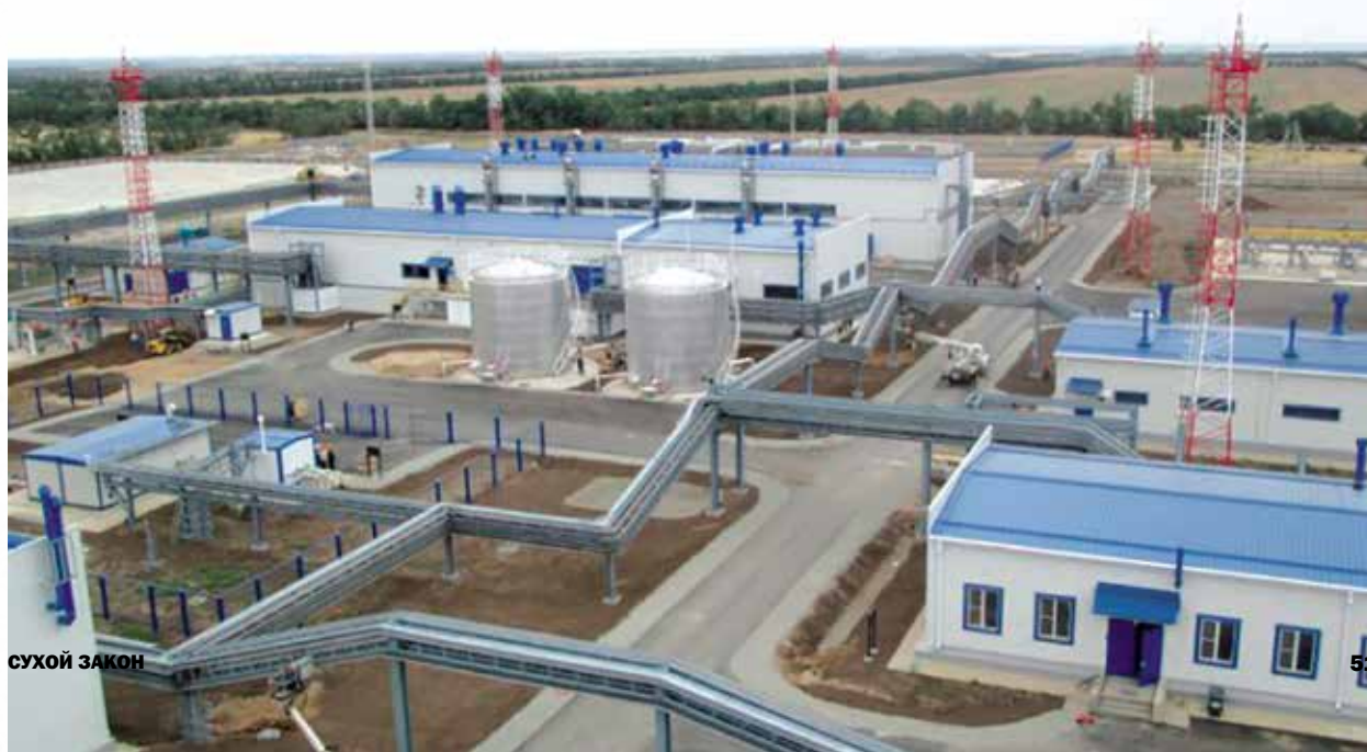
НПС-5 накануне пуска в эксплуатацию
