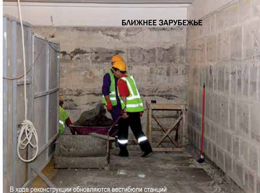
Подготовка поверхности и расшивка швов
