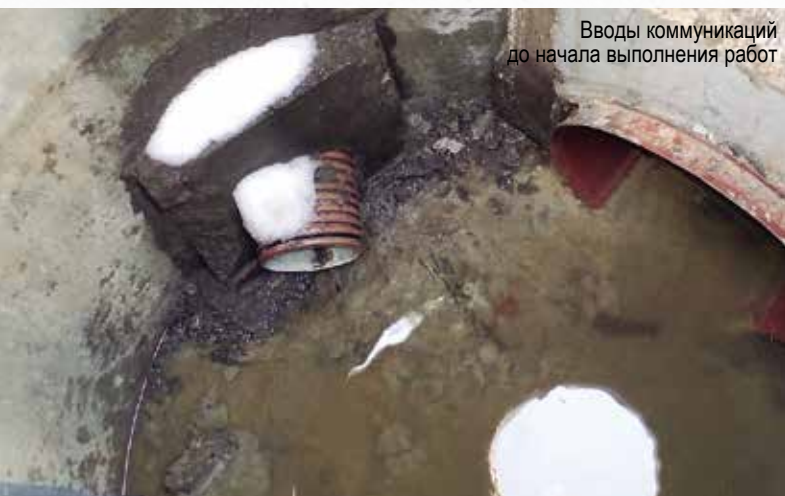
Герметизация мест вводов коммуникаций клеем-герметиком «Пенепокси»
