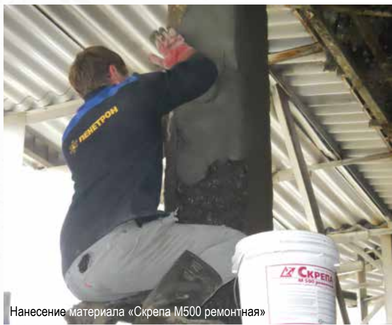
Процесс восстановления бетонных поверхностей
