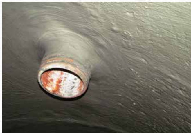
По окончании работ
