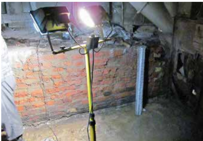
До начала работ
