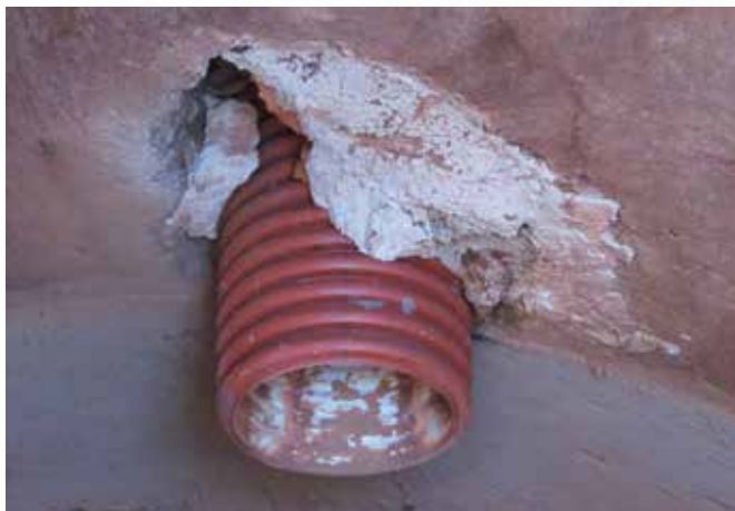
До начала работ
