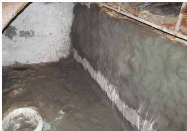
По окончании работ
