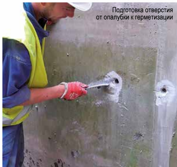
Гидроизоляция отверстий с применением материала «Пенекрит»
