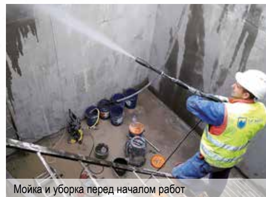
Очистка бетонной поверхности
