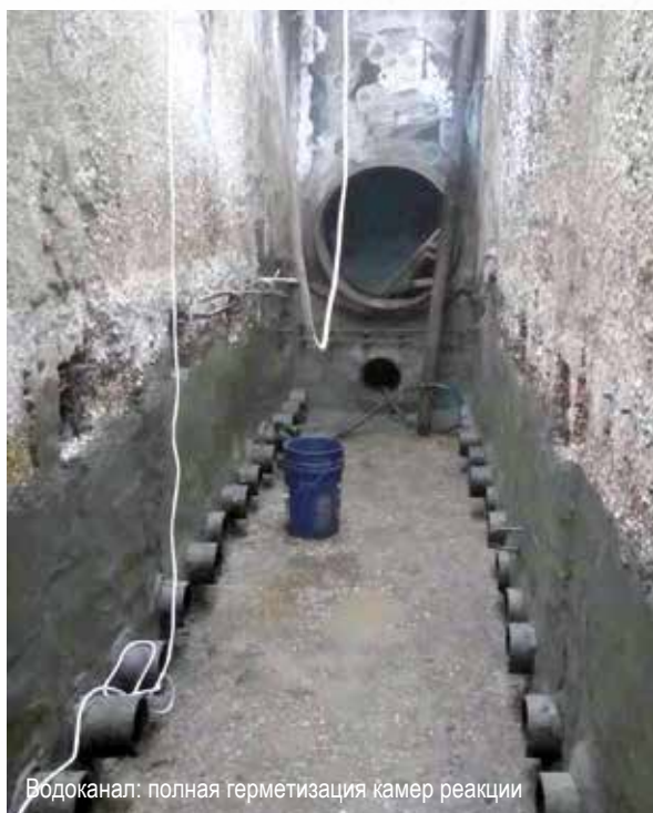
Восстановление бетонных конструкций с помощью «Скрепы М700»
