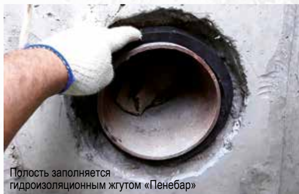
Уплотнение штрабы материалом «Пенекрит»
