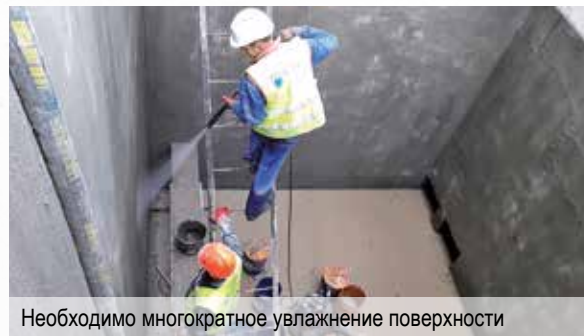
Увлажнение поверхности механизированным способом
