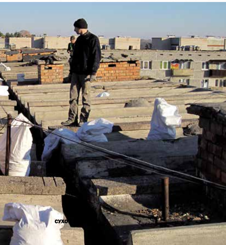
Разрушения кирпичной кладки короба вентиляционного канала
