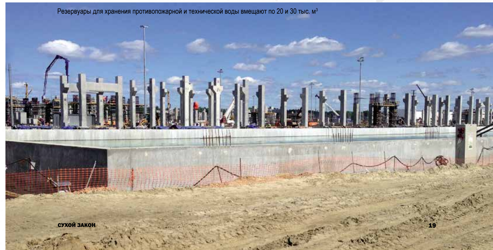
Резервуар заполнен водой для проверки надежности гидроизоляции
