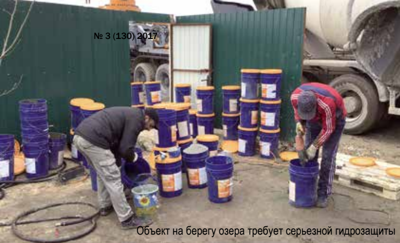
«Пенетрон Адмикс» добавляется непосредственно в бетоносмеситель
