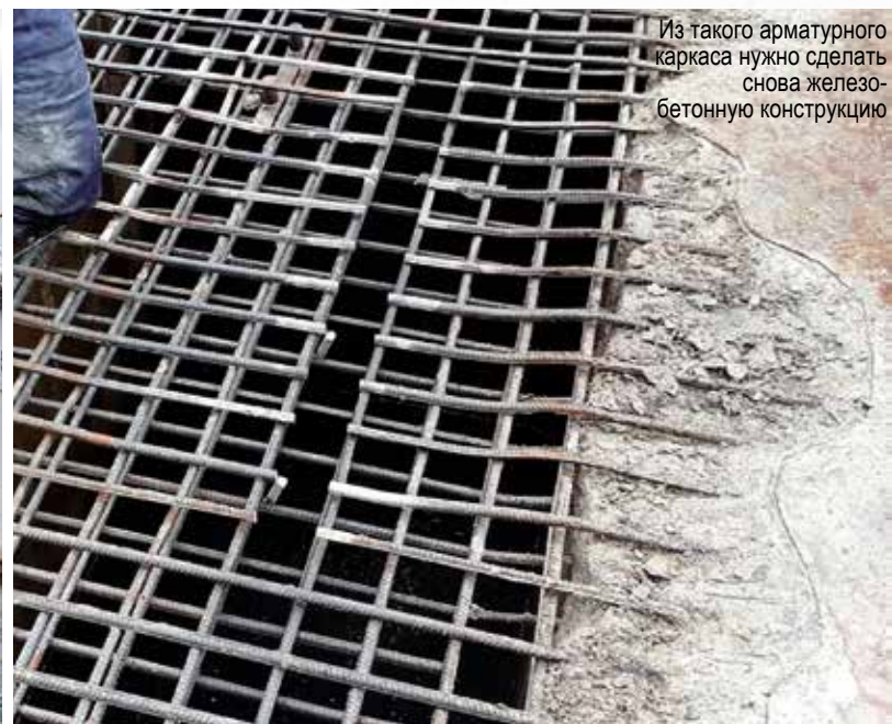
Подготовка к восстановлению поврежденной поверхности
